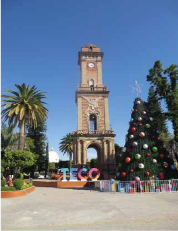
La tour et son horloge monumentale
